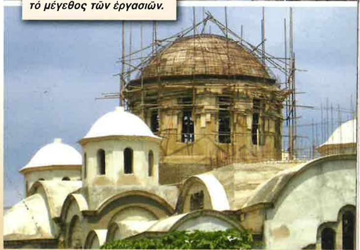
Ἐσωτερικὲς καὶ ἐξωτερικὲς λεπτομέρειες πού δείχνουν τὸ μέγεθος τῶν ἐργασιῶν.
